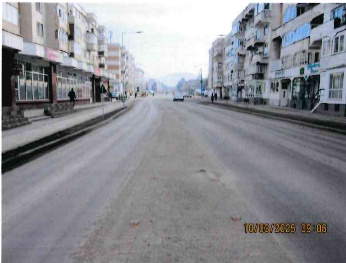
Figură 2-63 Starea carosabilului și a suprafeței pietonale pe Bulevardul Frăției
