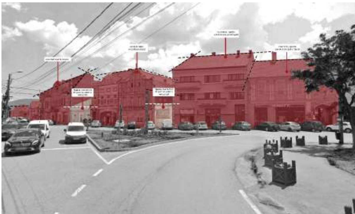
Figură 2-53 Frontul construit de la intersecția Străzii Piața Libertății cu Strada Strada Márton Áron
